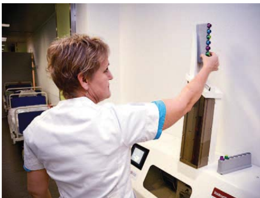
Bioanalytiker Anette Reimann demonstrerer, hvordan blodprøverne 'loades' i en afsenderstation på hospitalets nye rørpost-system (Tempus600 fra Timedico). Foto: Thomas Wittrup
