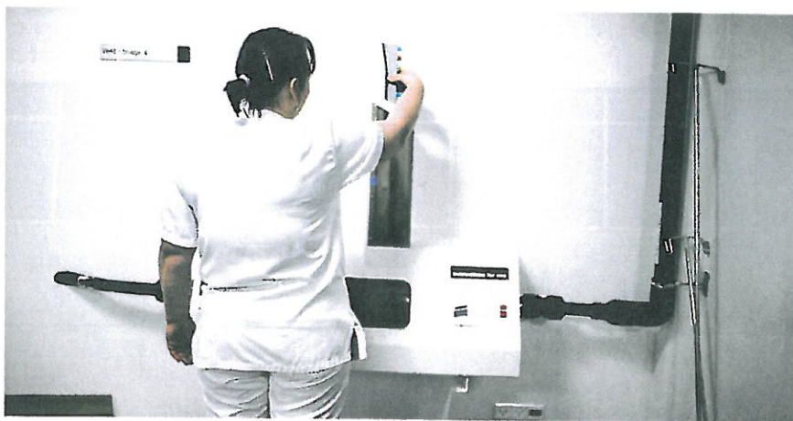
Maskinen skyder med lufttryk blodprøver over til laboratoriet 300 meter væk. Det sparer mange skridt.
